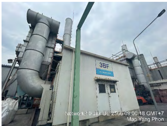
Bag Filter no.3 สำหรับนำอลูมิเนียมกลับมาใช้ใหม่
