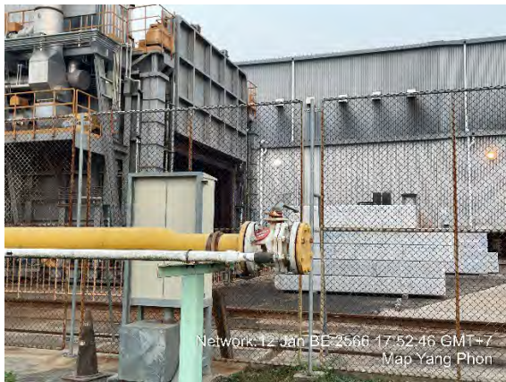
ภาพที่ 2-37 (ต่อ) Insulation Joint/Flang
